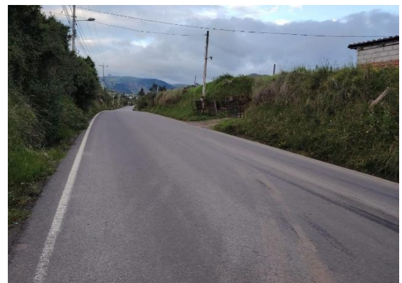
Fotografía 9. Vía Asfaltada Olmedo
