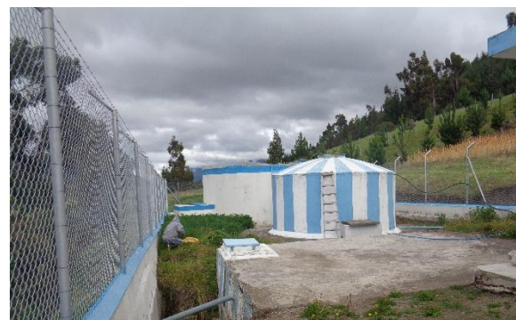
Fotografía 8. Tanque de agua potable de Olmedo
